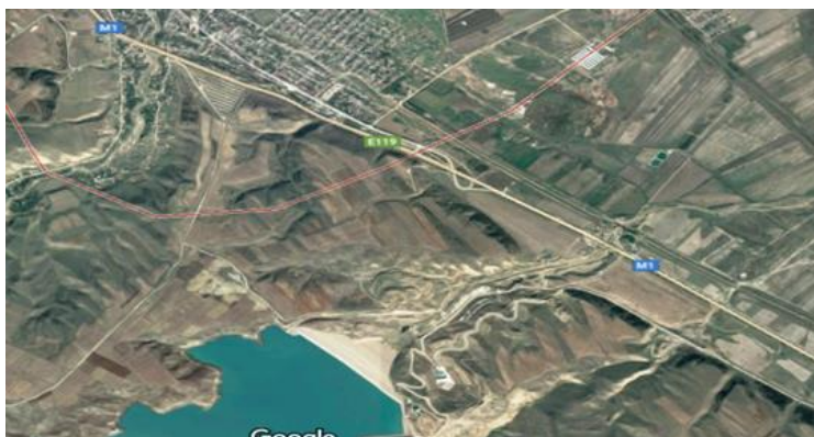
Рис. 1. Плотина Тахтакорпюнского водохранилища
