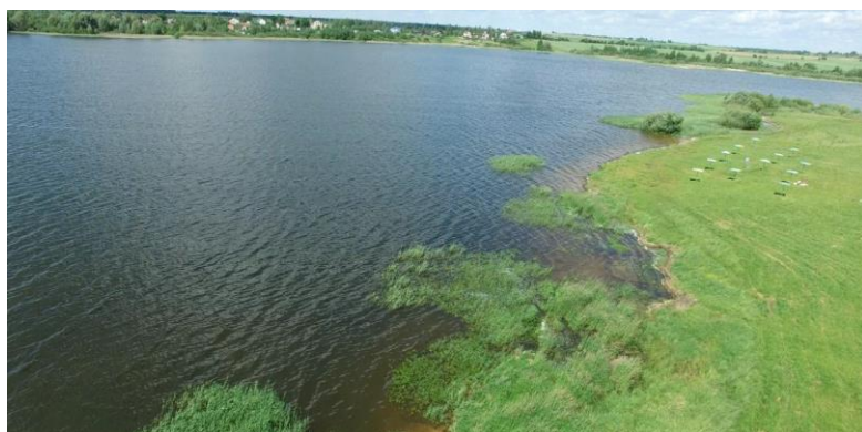
Рис. 2. Водохранилище Петровичи. Подтопление левого берега
