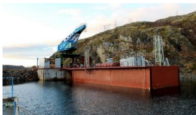
Рис. 3. Кислогубская приливная электростанция (ПЭС)
