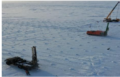
Рис. 1. Производство буровых работ на льду
