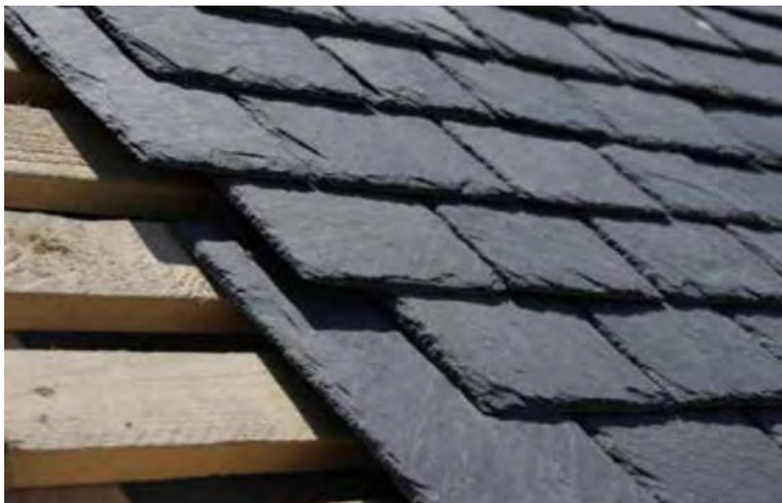
Рис.19.21. Монтаж кровельного сланца
