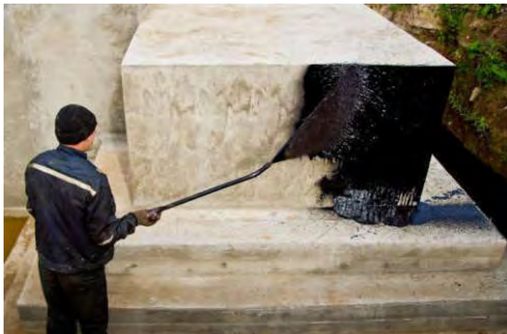
Рис. 19.1. Нанесение битумной эмульсии
