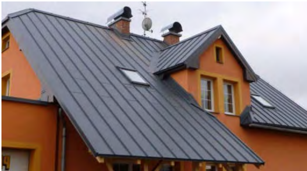
Рис. 19.15. Фальцевая кровля
