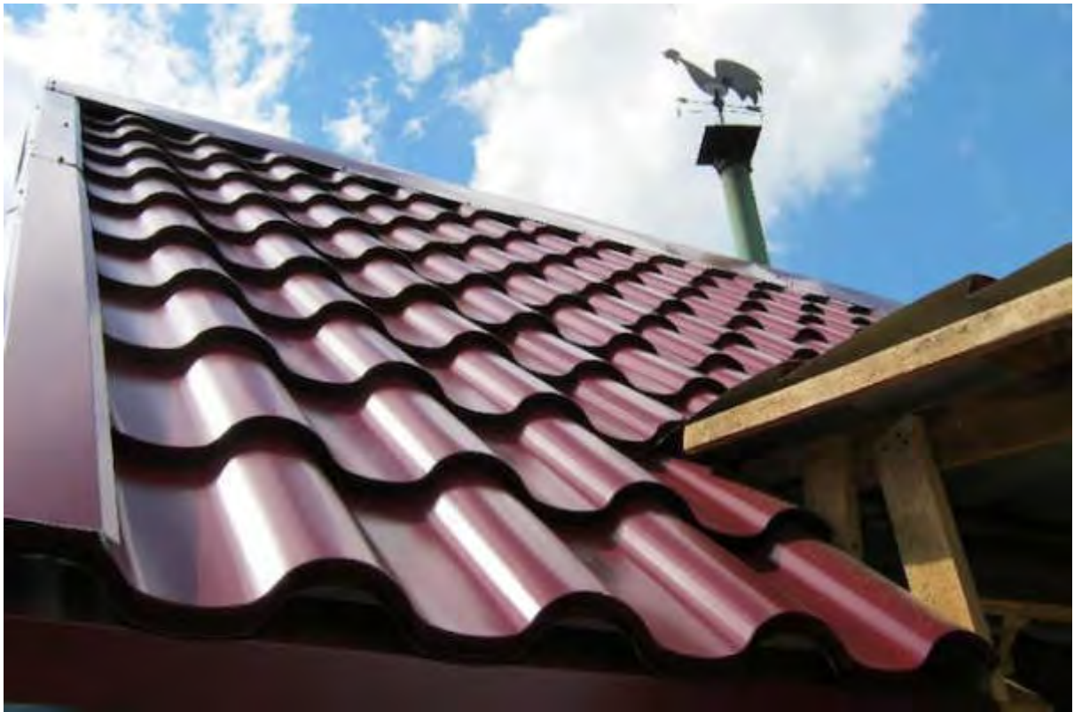
Рис.19.16. Крыша из металлочерепицы
