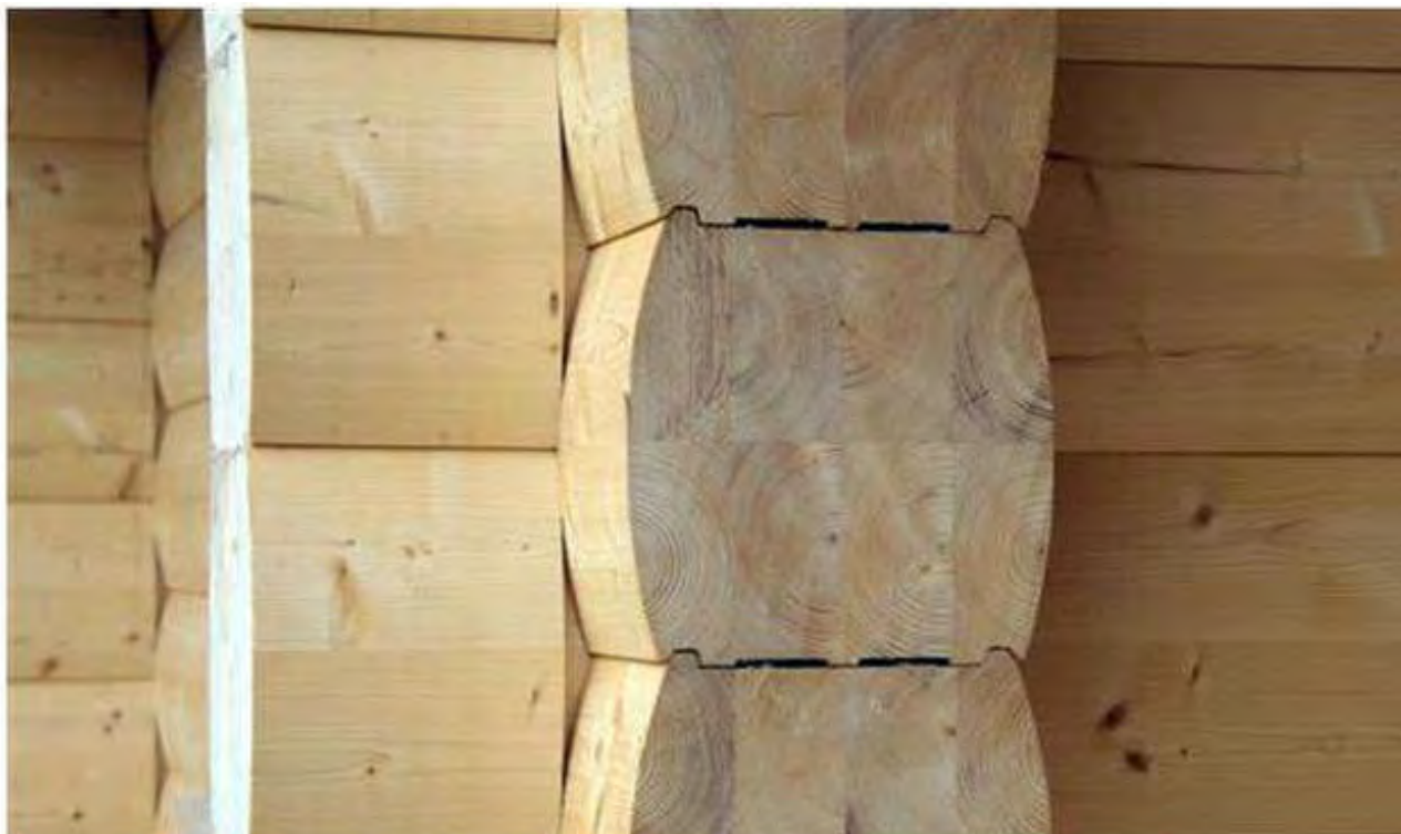
Рис.4.33. Фрагмент здания из клееного бруса
