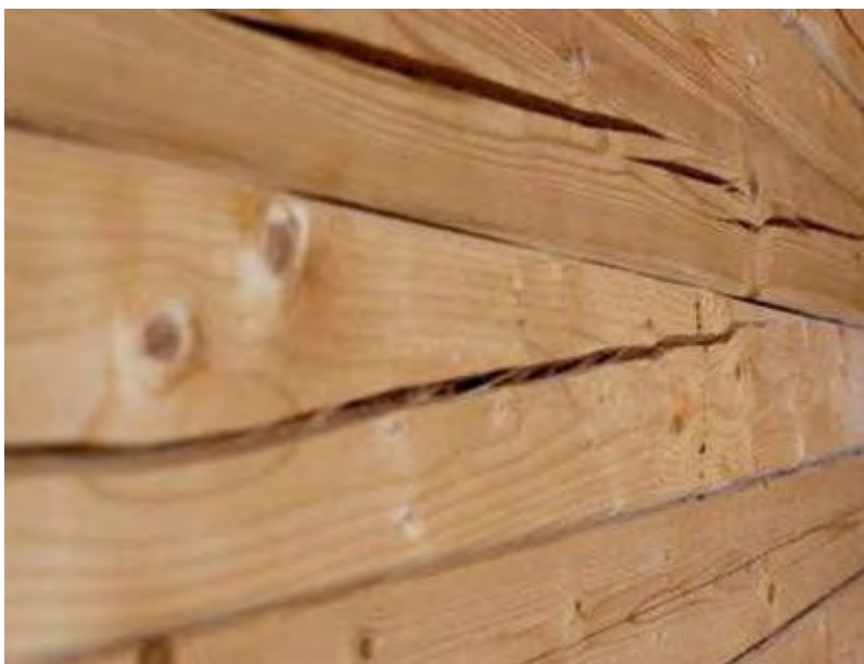
Рис.3.9. Растрескивание древесины
