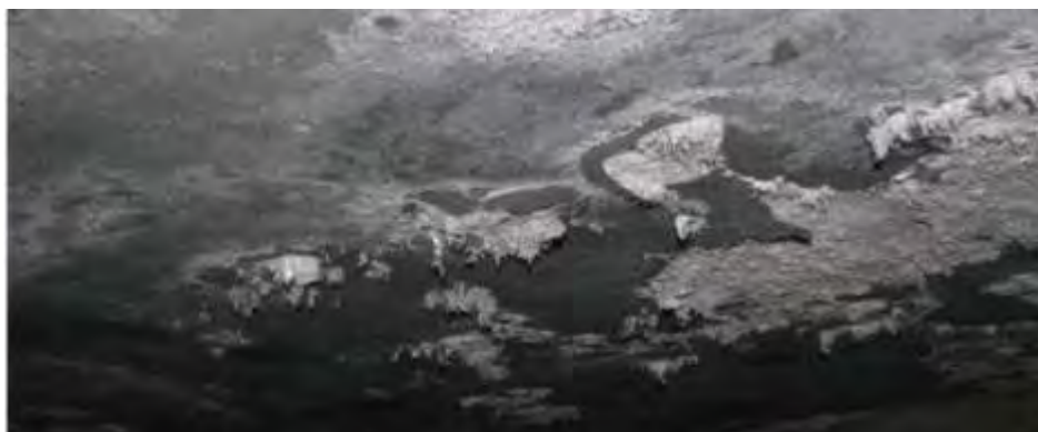
Рис. 9.10. Выстыл на потолке
