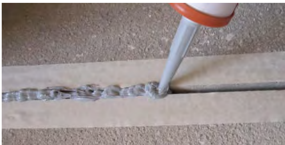
Рис. 20.3. Заполнение шва герметиком
