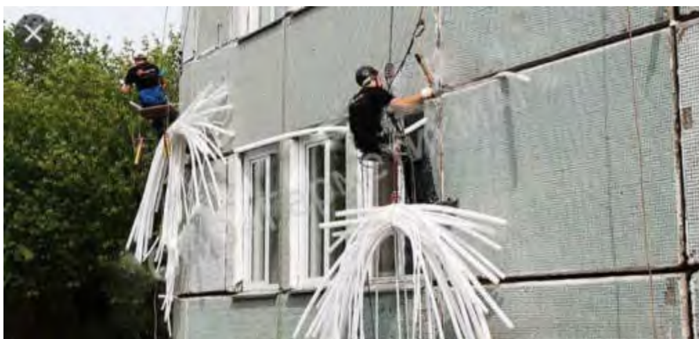
Рис. 20.14. Герметизация межпанельных швов жгутами
