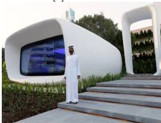
Рис. 2. Первый дом, построенный в Дубае 3D-принтером
