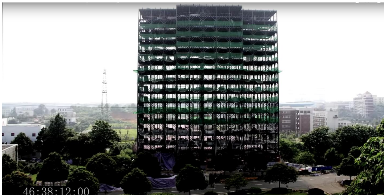
Рисунок 3 – Конец строительства несущих конструкций через 46 часов
