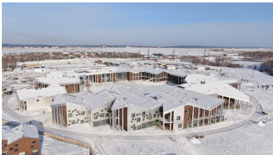
Рис. 3. Образовательный комплекс «Точка будущего» в Иркутске, Архитектурная концепция: СЕВРА, UNK Руководитель авторского коллектива: Борисов Ю.; архитектура: Борисов Ю.; интерьеры: Тряскина Ю.; архитекторы: Волков И., Тряскина Т.; главный инженер: Цукерман А.; Ландшафтный дизайн: Vega landskab, 2015–2020 [1]
