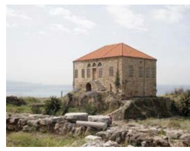
Рис. 6. Дом Аль-Хузами. Этот типичный ливанский дом, основанный в непосредственной близости от замка Библос. Этот дом был построен, скорее всего, во второй четверти XIX в. (Источник: Фото автора, 2021)
