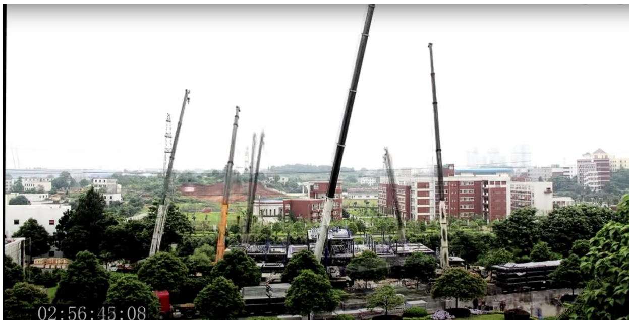
Рисунок 2 – Начало строительства отеля
