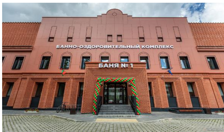
Рисунок 2 – Фото бани №1 после реконструкции
