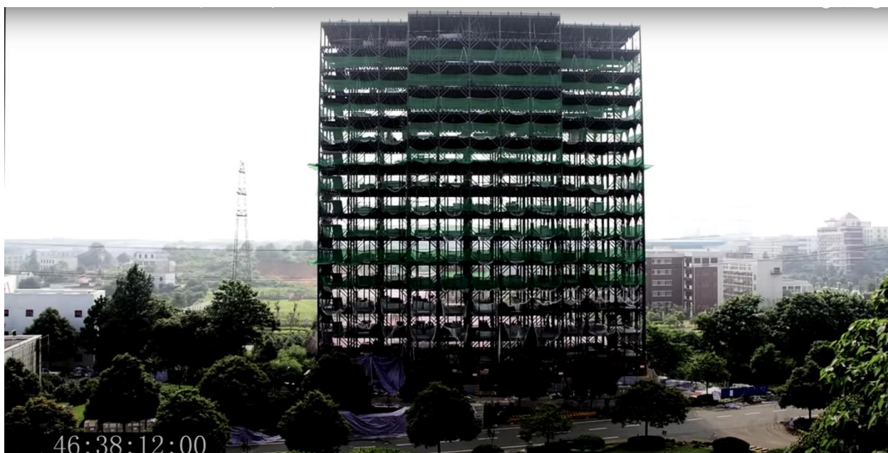
Рисунок 3 – Конец строительства несущих конструкций через 46 часов
