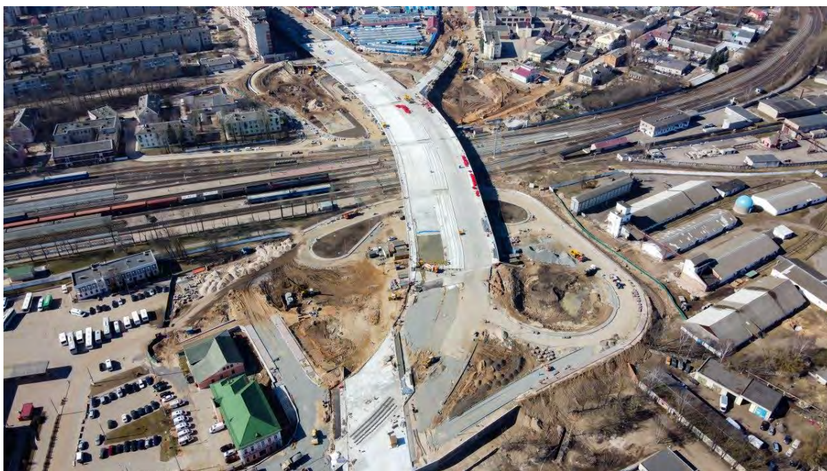
Рисунок 1 – строительство Полоцкого путепровода
