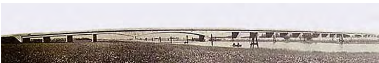
Рисунок 1 – общий вид моста до обрушения
