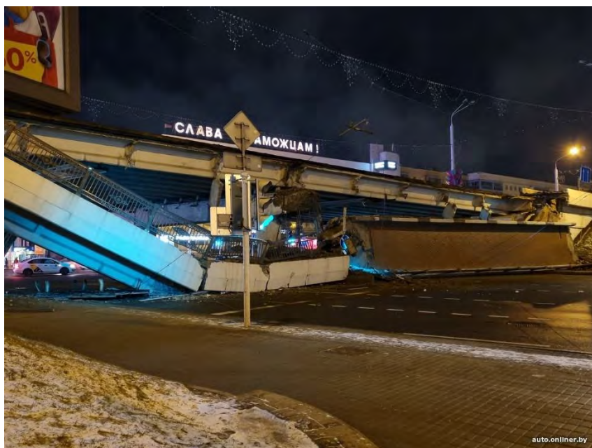
Рисунок 1 – Путепровод на Немиге
