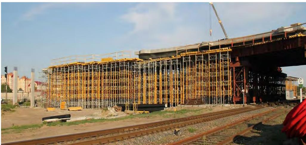
Рисунок 2 – Производство монолитных работ на подмостях
