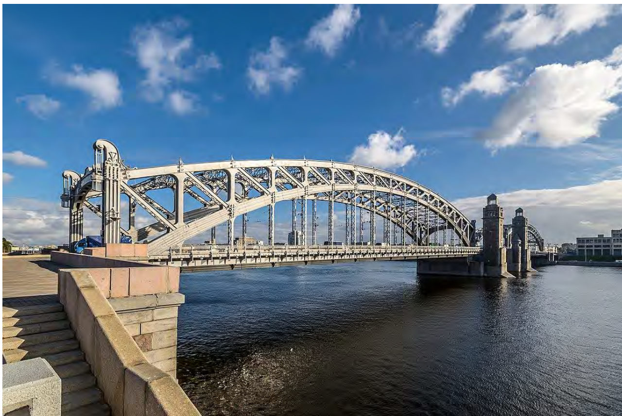
Рисунок 1 – Общий вид Большеохтинского моста
