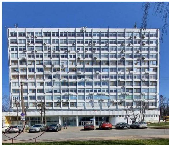
Рис. 4. Здание ГП «Институт «Белстройпроект». Фасад юго-западной ориентации; для регулирования микроклимата помещений используются сплит-системы, некоторые оконные проемы изнутри закрыты листами фольги или шторами (фото автора)
