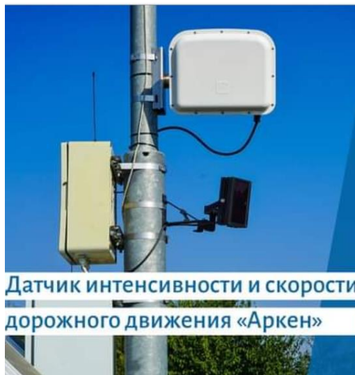
Рисунок 1 – Датчик интенсивности и скорости дорожного движения «Аркен»
