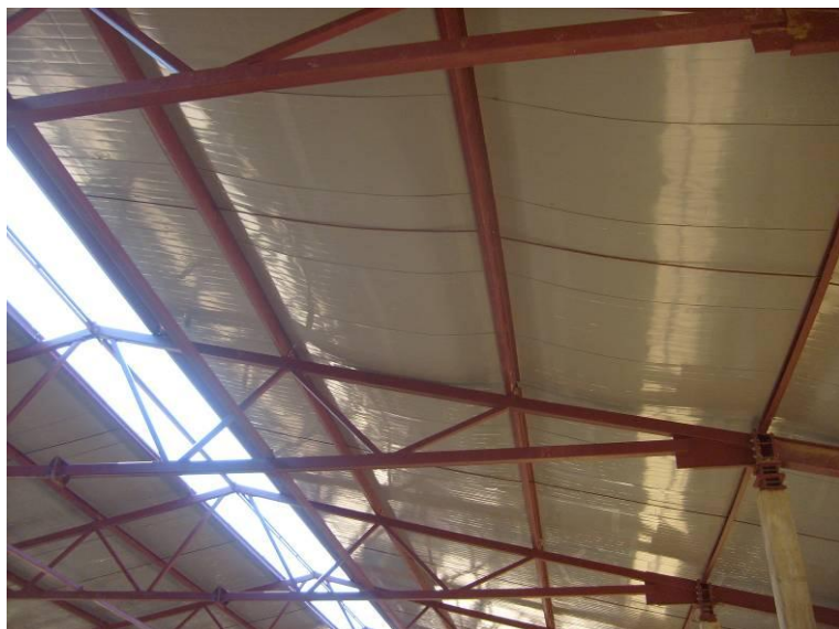
Рисунок 5. Прогобы в пролете «А-В» трехслойных панелей с утеплителем из минераловатных плит.
