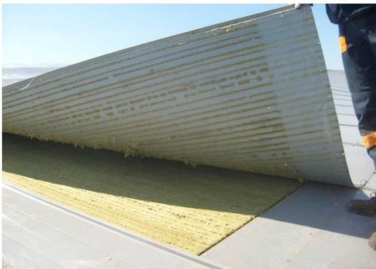
Рисунок 3. Расслоение трехслойных панелей с утеплителем из минераловатных плит.
