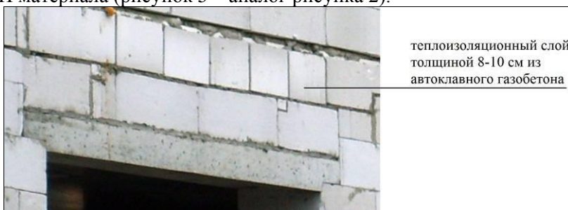
Рисунок 5. Фрагмент фасада строящегося дома со стенами из АГБ, утепленного в уровне перекрытия плитами из АГБ (консольный выступ – 8-10 см; железобетонные перемычки выполнены из тяжелого цементного бетона)
