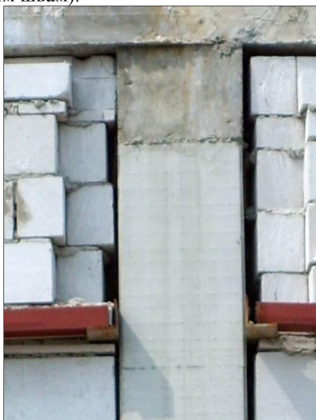
Рисунок 8. Фрагмент фасада строящегося дома со стенами из АГБ (консольный выступ стены 8-10 см)
