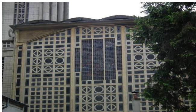
Рисунок 3. Фрагмент фасада. Фото автора
