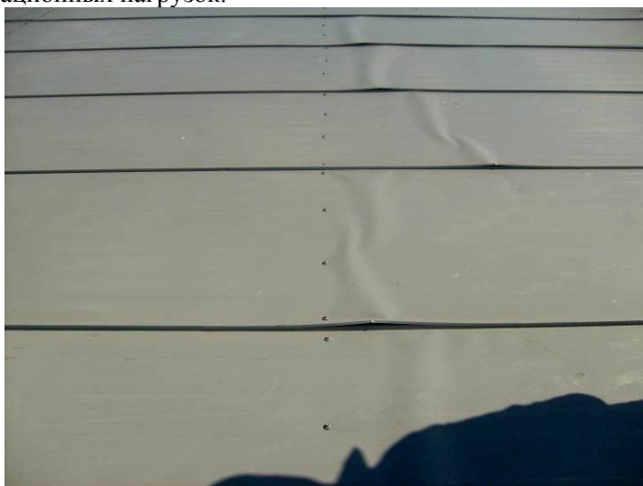
Рисунок 2. Отслоение верхней обшивки на промежуточной опоре трехслойных панелей с утеплителем из минераловатных плит.
