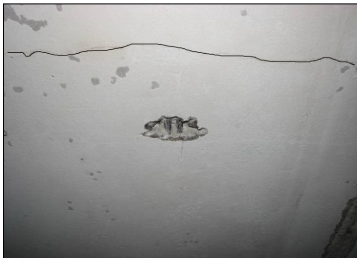
Рисунок 5. Поперечные трещины в плитах перекрытия
