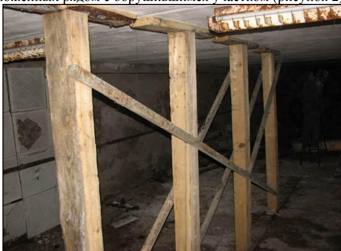
Рисунок 2. Конструкция временного усиления плит перекрытия
