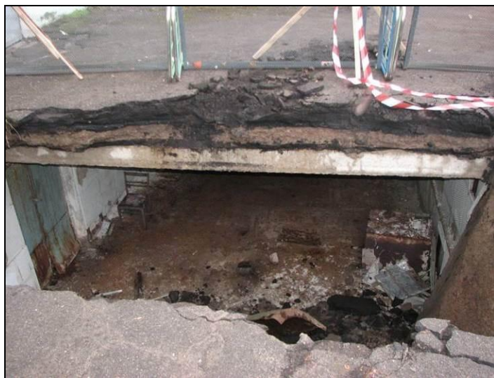
Рисунок 1. Участок обрушение плит перекрытия
