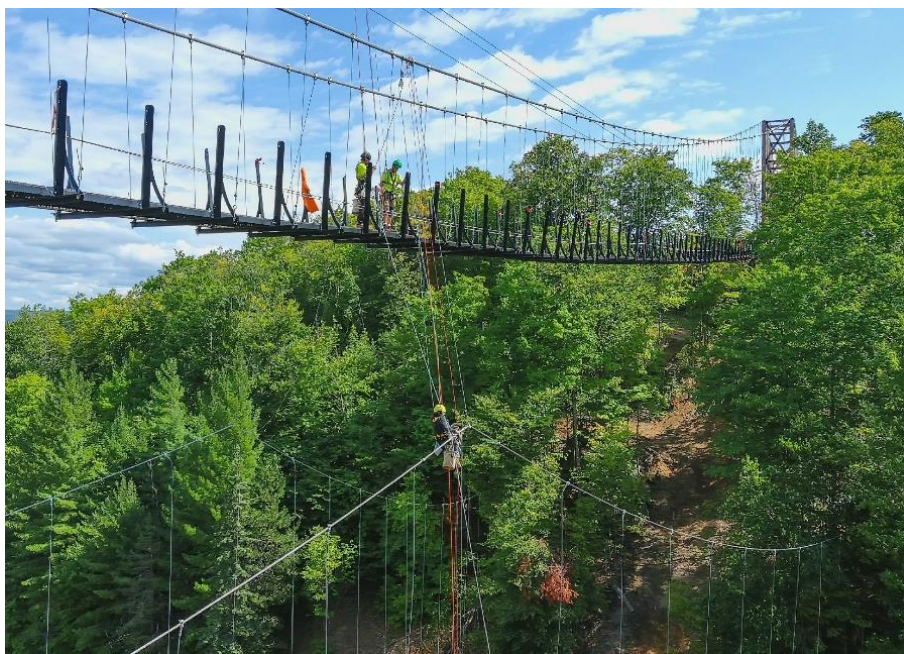
Рисунок 3 – Монтаж канатов ветряных растяжек
