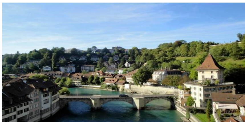
Рис. 2. Внешний вид моста Унтерторбрюкке
