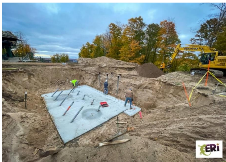
Рис. 1. Устройство опоры под пилоны
