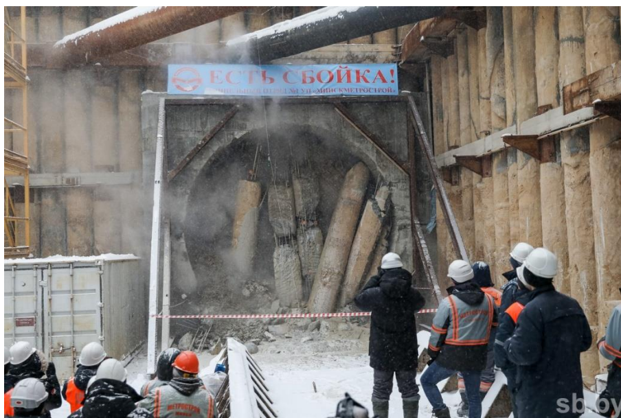
Рис. 5. Тоннельный щит «Алеся». Окончание работ по проходке тоннеля — выход щита на поверхность
