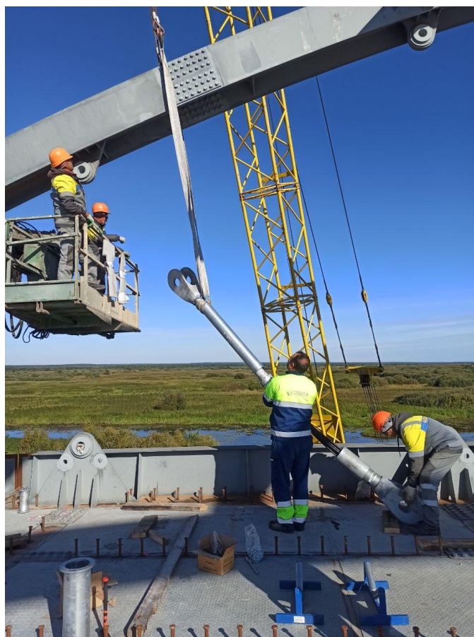
Рисунок 5 – Монтаж собранной конструкции
