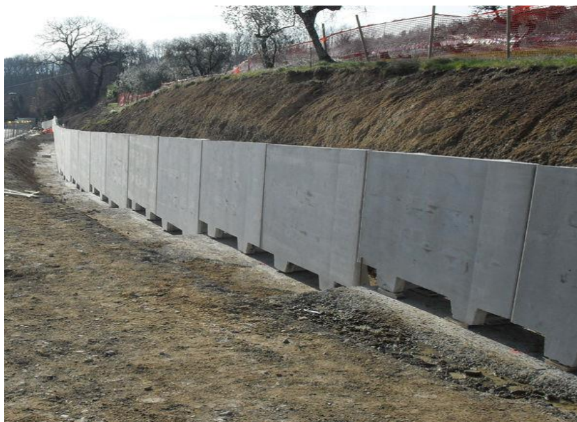
Рисунок 3 – Подпорные стенки
