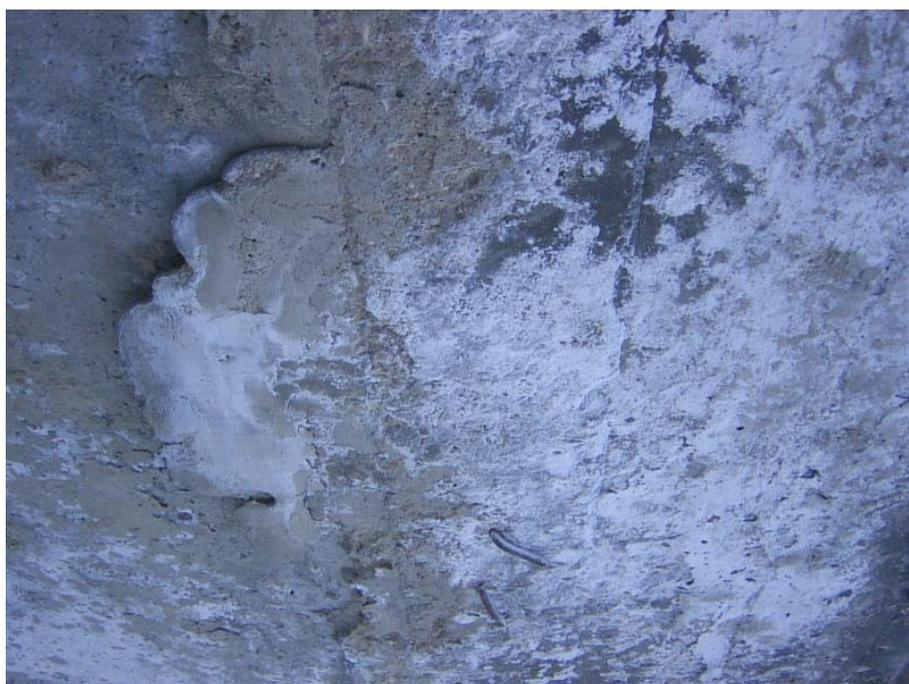
Рисунок 1 – Выщелачивание поверхности
