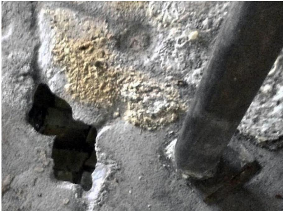
Рисунок 2 – Кислотная деструкция
