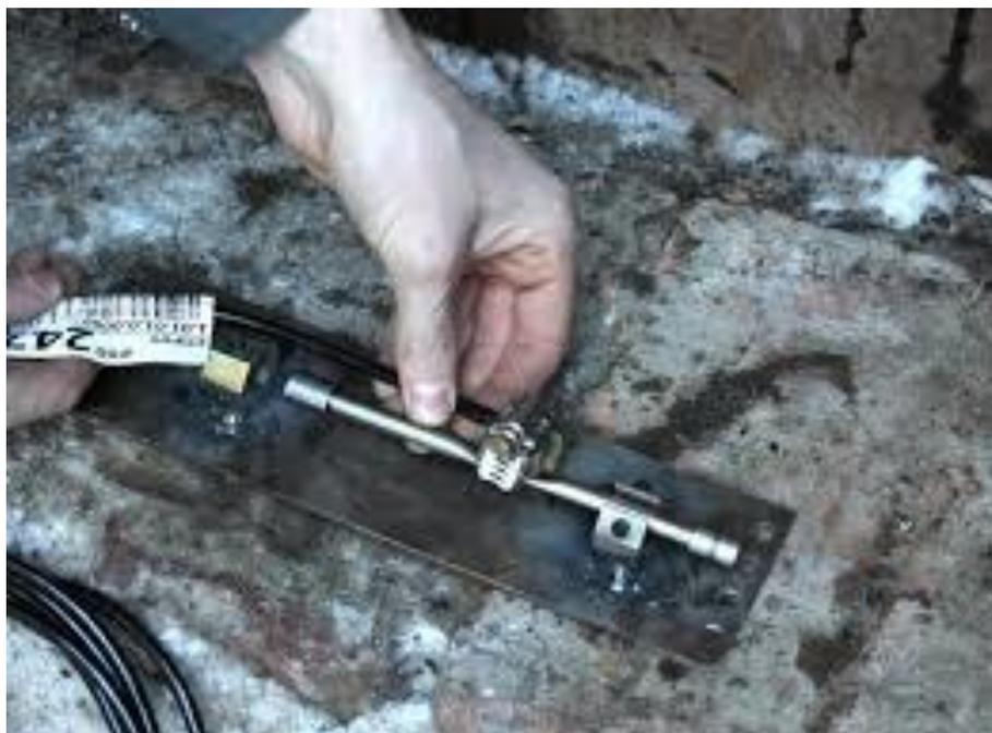
Рисунок 2 – Процесс установки накладного струнного тензомера
