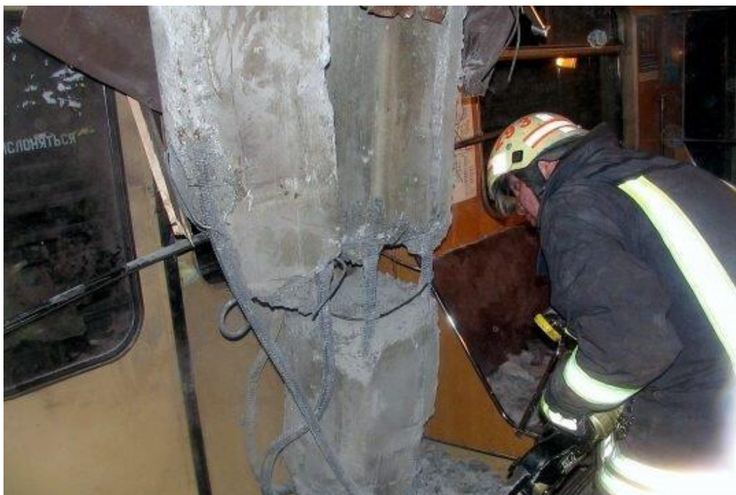
Рисунок 1 – Демонтаж застрявшей сваи
