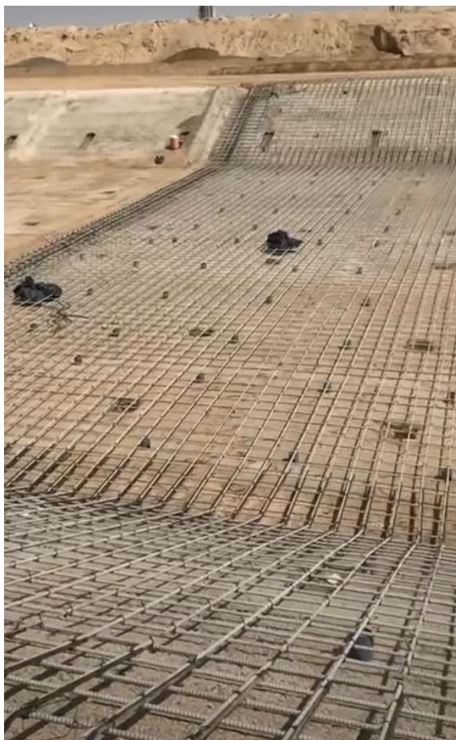
Рисунок 5 – Применение композитной арматуры при строительстве канала в Саудовской Аравии
