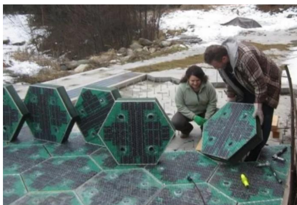
Рисунок 4 – Укладка панелей Solar Roadways вручную [3]
