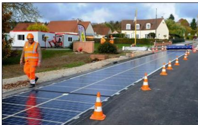
Рисунок 2 – Покрытие автомобильной дороги из фотоэлектрических панелей (Wattway, Франция) [4]
