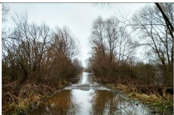
Рисунок 12. Дорога в Старобинском лесхозе, подтопленная весенним паводком
