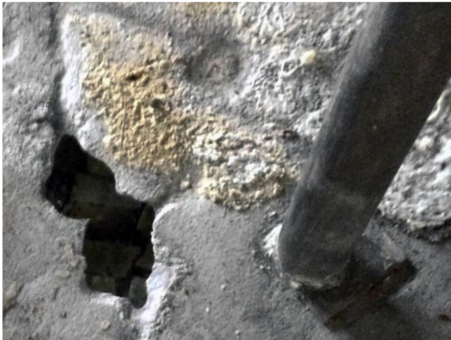
Рисунок 2 – Кислотная деструкция
