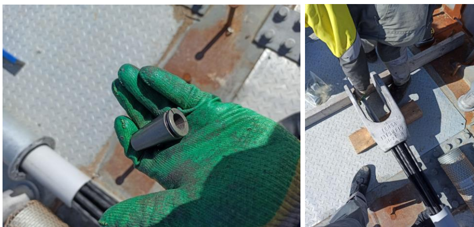
Рисунок 4 – Зацангивание кабелей в отверстиях анкерных муфт
