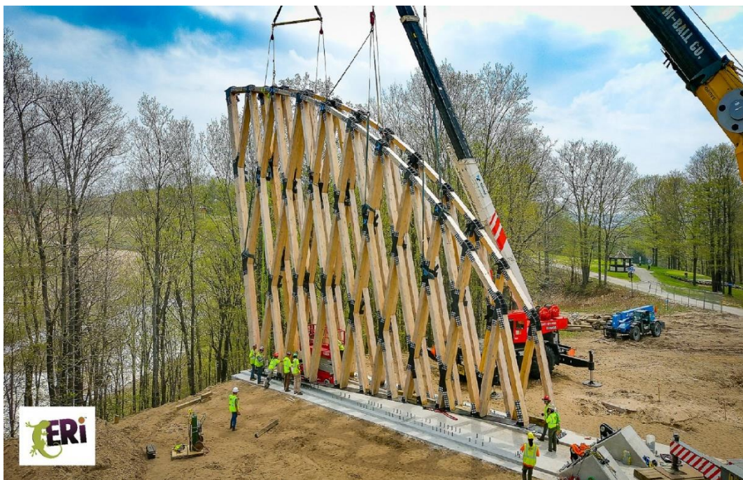
Рисунок 2 – Сборка ферм
