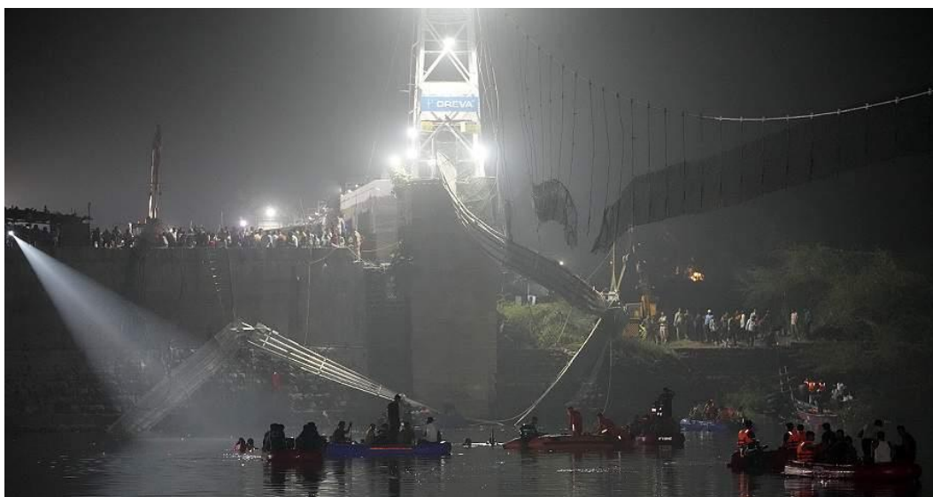
Рисунок 1 – Мост через реку Мачху после разрушения
