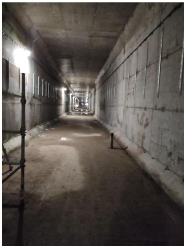
Рисунок 3 – Тоннель, возведённый открытым способом
