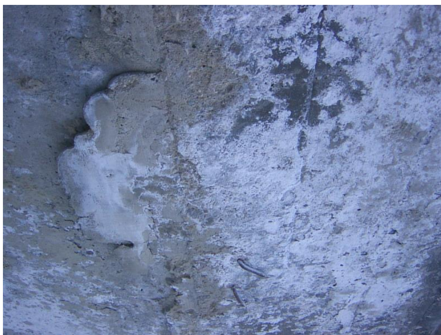
Рисунок 1 – Выщелачивание поверхности
