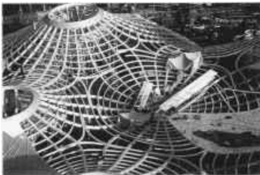
Рисунок 2 – Строящаяся оболочка крыши
