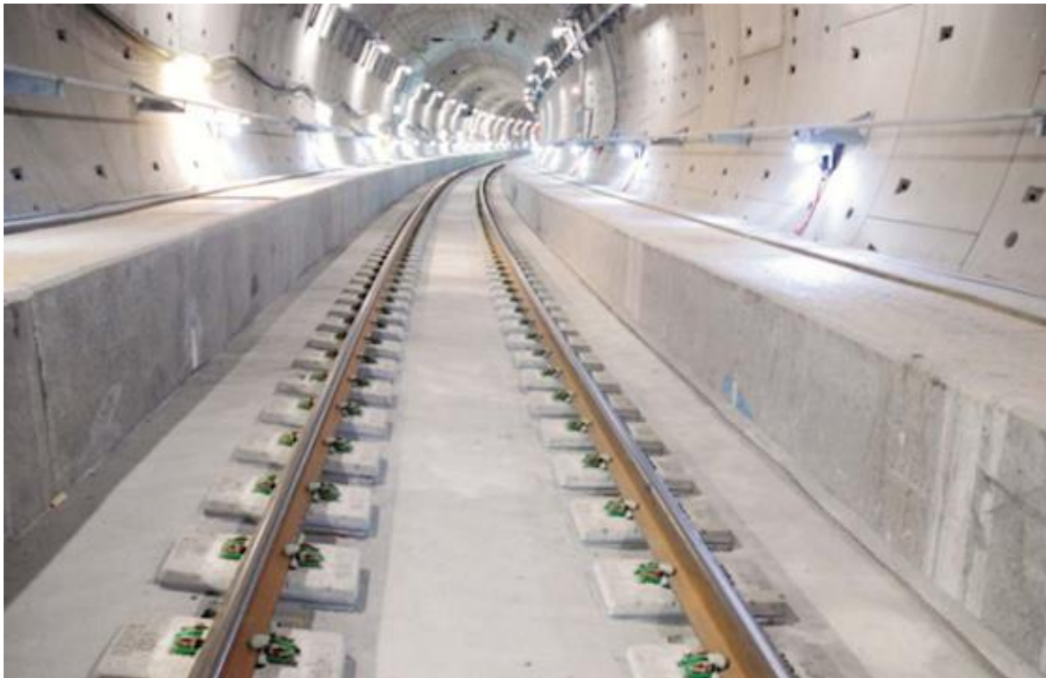
Рисунок 2 – Путь пониженной вибрации LVT (Low Vibration Track)
