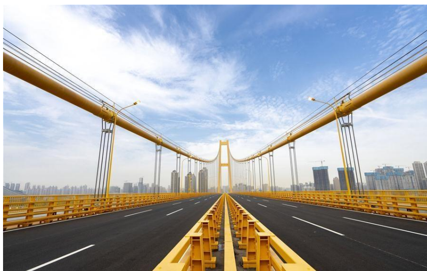
Рисунок 3 – Проезжая часть моста
