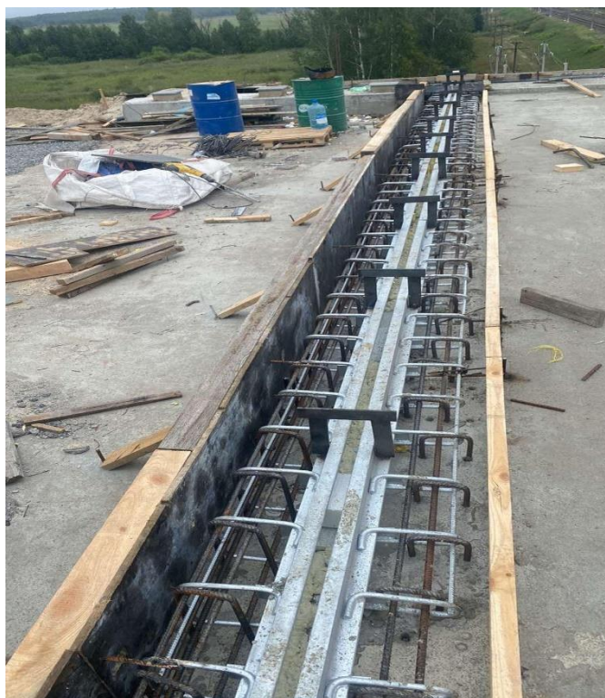
Рисунок 1 – Деформационный шов типа Маурер
