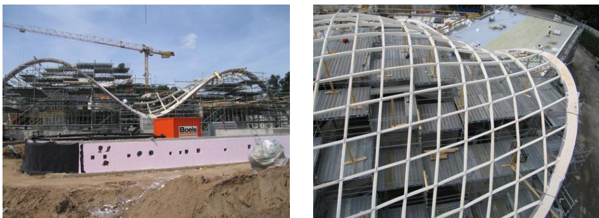
Рисунок 3 – Монтаж конструкции крыши
