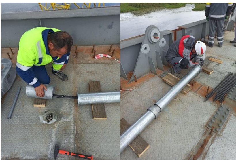
Рисунок 3 – Процесс вставки кабелей в отверстия анкерной муфты
