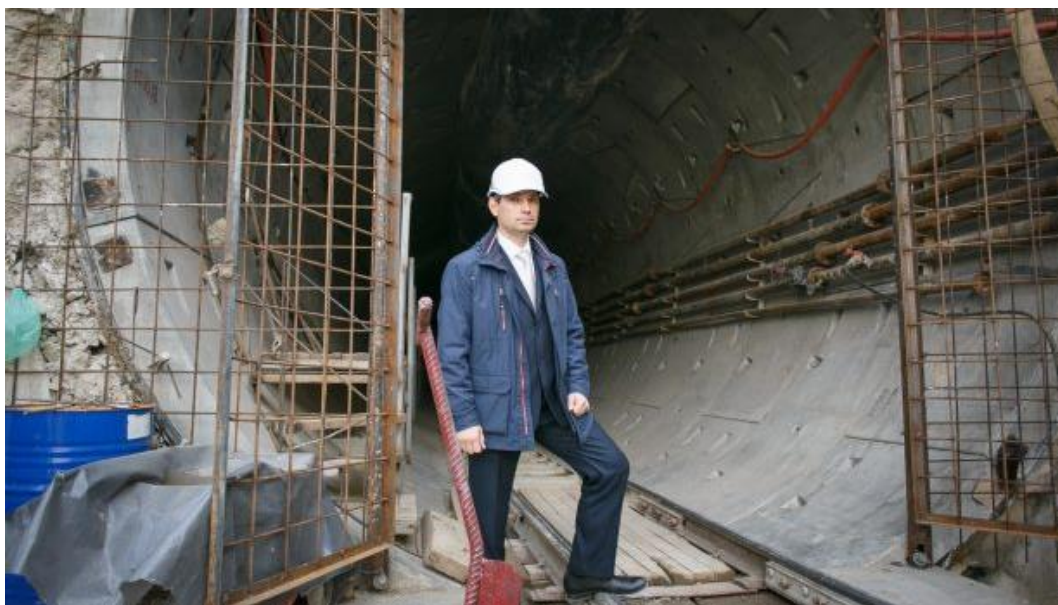
Рисунок 2 – Вход в тоннель, пройденный щитом «Алеся»
