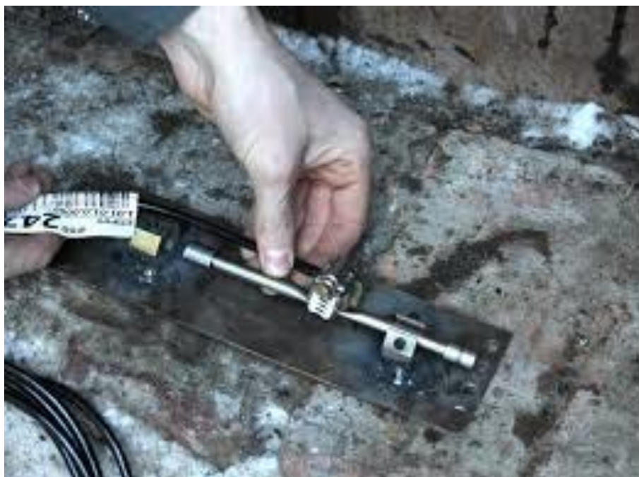
Рисунок 2 – Процесс установки накладного струнного тензOMETра
