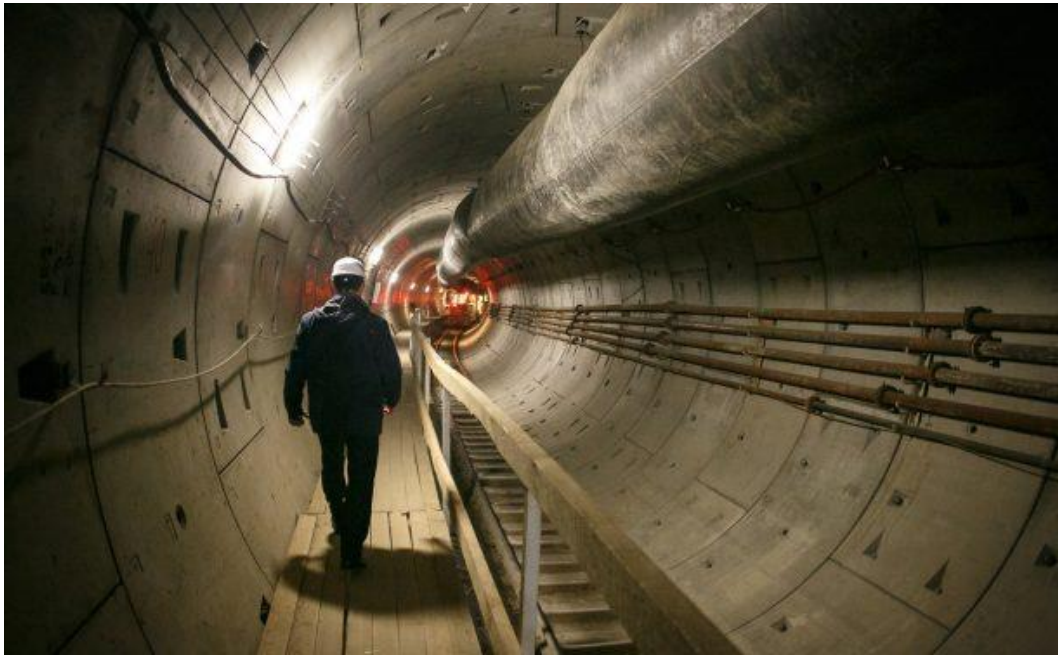
Рисунок 1 – Вид тоннеля за проходческим щитом «Алеся»
