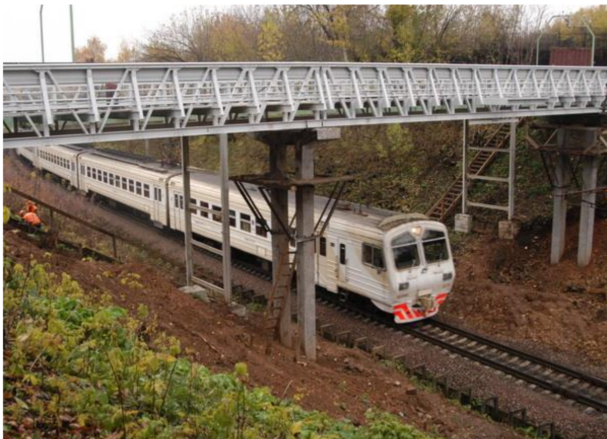
Рисунок 1 – Общий вид сооружения
