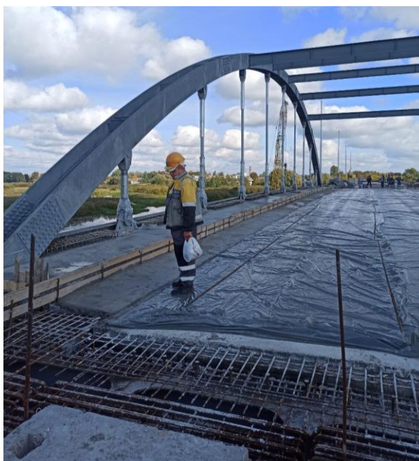
Рисунок 1 – Система подвесок (вант) арочного пролетного строения
