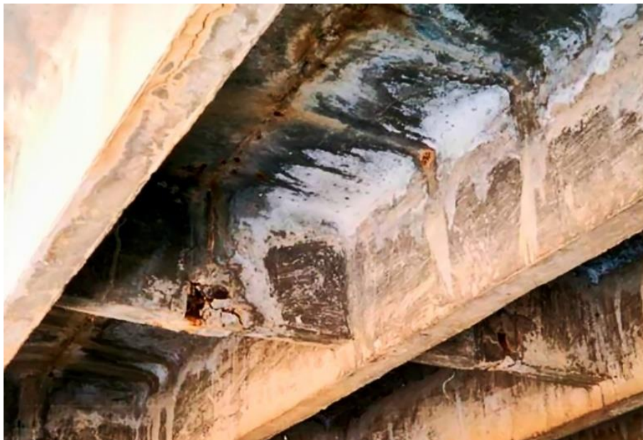
Рисунок 3 – Солевая коррозия
