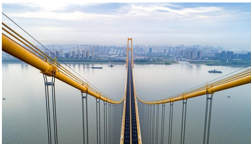
Рисунок 2 – Вид с пилона мост Янсыган
