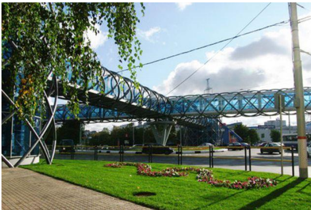
Рисунок 1 – Общий вид сооружения
