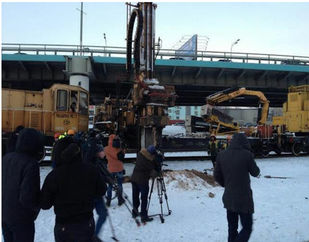
Рисунок 2 – Дизель-молот для забивания свай на месте происшествия
