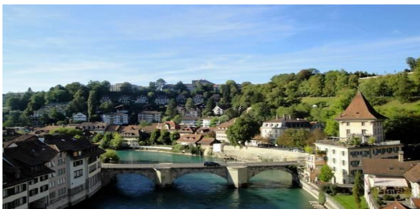
Рис. 2. Внешний вид моста Унтерторбрюкке
