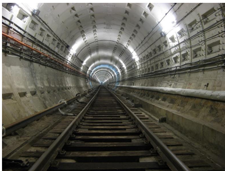
Рис. 2. Перегонный тоннель с использованием тоннельной обделки старого образца
