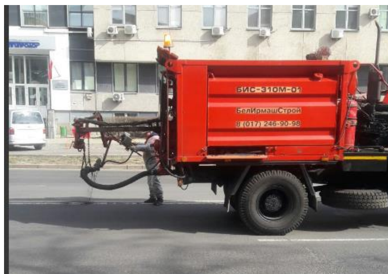
Рис. 5. Ремонт асфальтобетонного покрытия струйно-инъекционным способом с помощью щебня установкой БИС-310М-01
