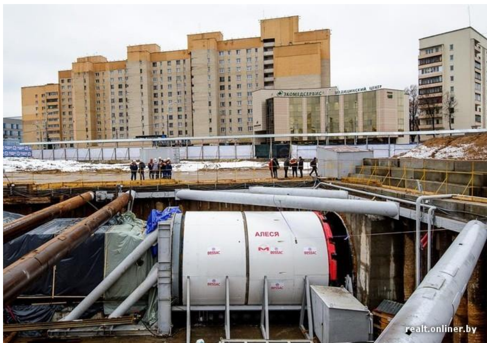
Рис. 2. Тоннельный щит «Алеся». Начало проходки первого тоннеля
