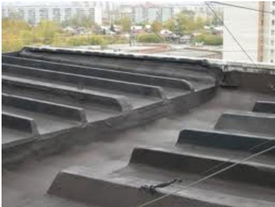
Рис. 1. Гидроизоляция жидкой резиной сложной крыши
