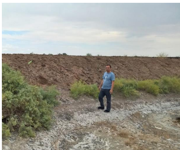
Рис. 1. Земляное полотно из засоленного грунта
