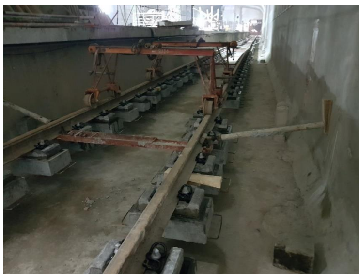
Рис. 3. Подготовка верхнего строения пути на блоках БВ2-М к бетонированию
