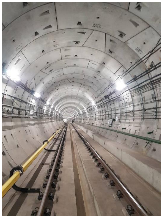
Рис. 1. Перегонный тоннель из железобетонных тубингов высокоточной тоннельной обделки
