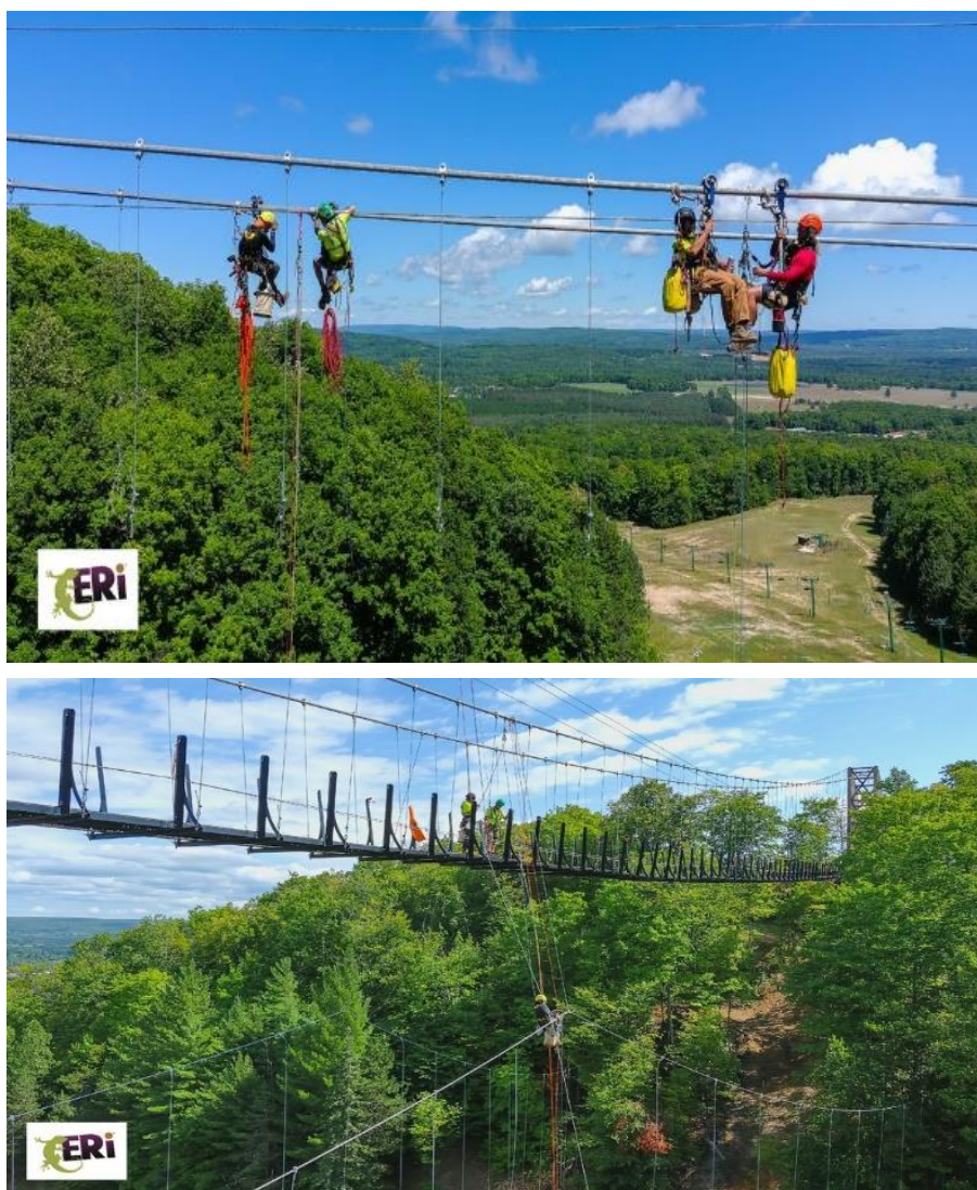
Рис. 4. Монтаж подвесок и тросов ветряных растяжек
