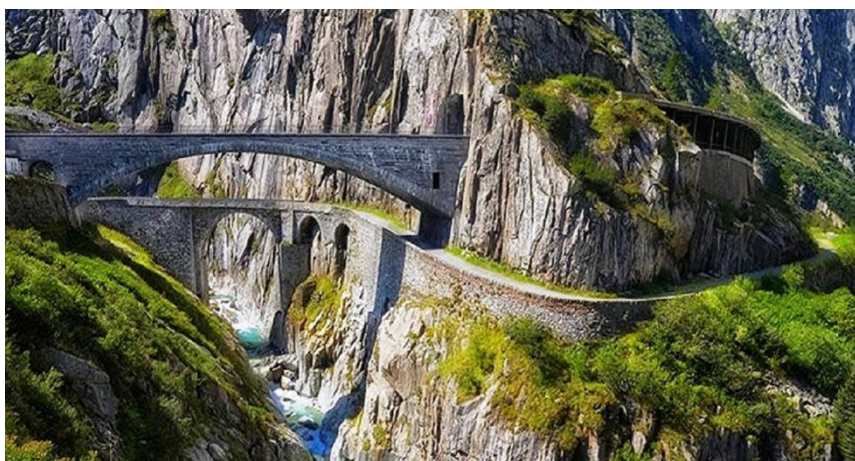
Рис. 3. Внешний вид моста Тейфельсбрюкке
