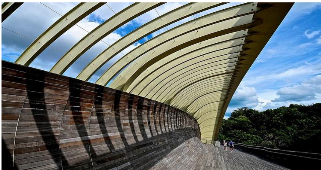
Рис. 5. Мост «Волны Хендерсона», вид изнутри
