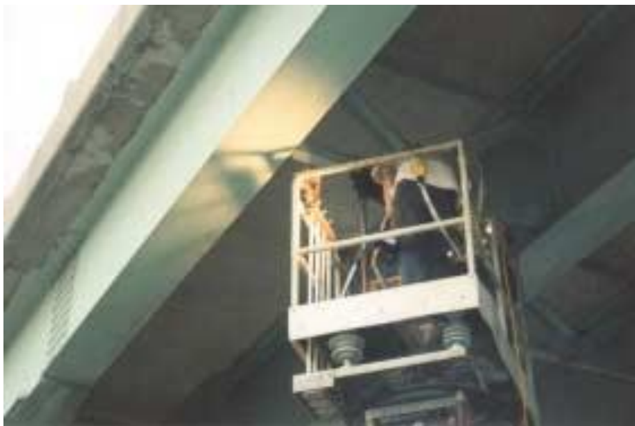
Рис. 3. Тепловой контроль узла соединения поперечной связевой рамы со стенкой стальной балки автодорожного моста (с использованием подъемника) [7]
