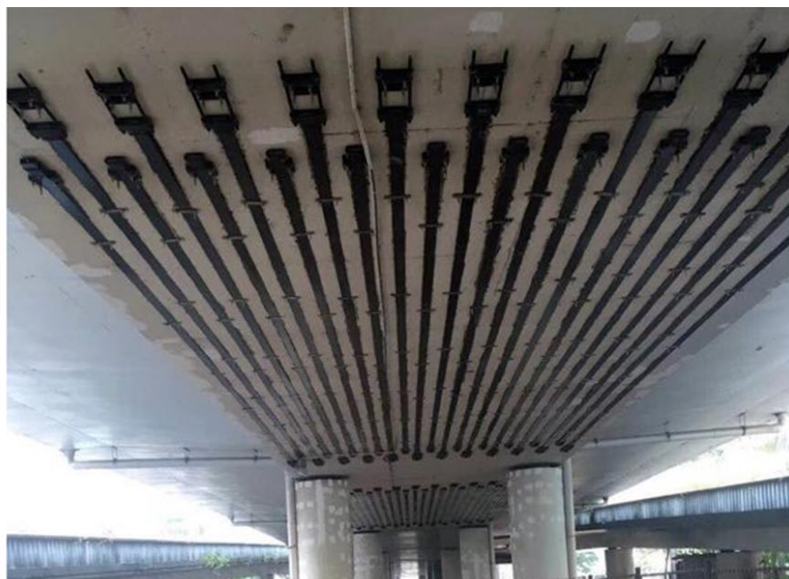
Рис. 2. Мост с применением полимерных композитных пластмасс
