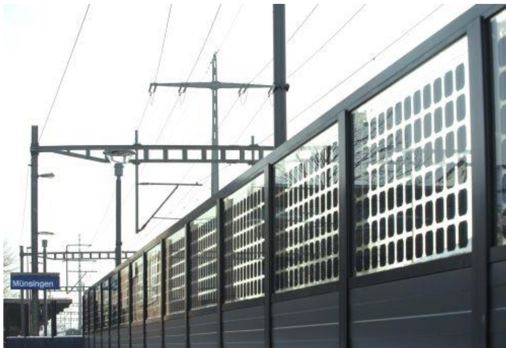
Рис.3.Инновационный шумозащитный экран с фотоэлектрическими панелями
