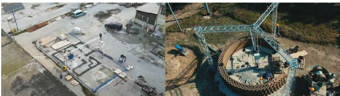
Рис.2 . Портальный 3D-принтер BetAbram P1 и принтер типа дельта WASP Crane WASP “Infinity 3D Printer”
