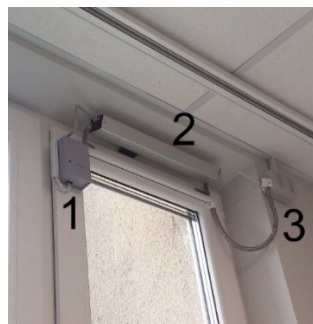
1 – микроконтроллерный блок управления; 2 – цепной электропривод; 3 – концевой выключатель
