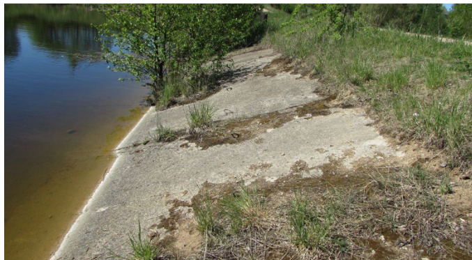
Рисунок 1 – Верховой откос земляной плотины
