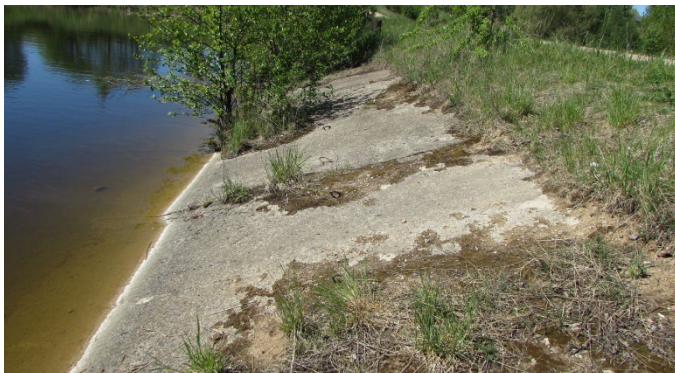
Рисунок 1 – Верховой откос земляной плотины
