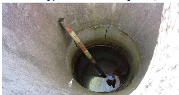
Рисунок 2 – Смотровой колодец трубчатого дренажа земляной плотины
