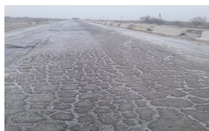
Рисунок 2 – Примеры разрушения покрытия
