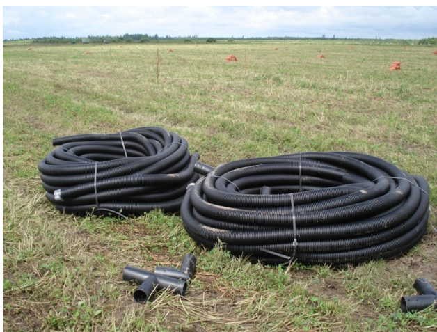
Рисунок 7. – Трубы полиэтиленовые дренажные без перфорации диаметром 90 мм для устройства коллекторов
