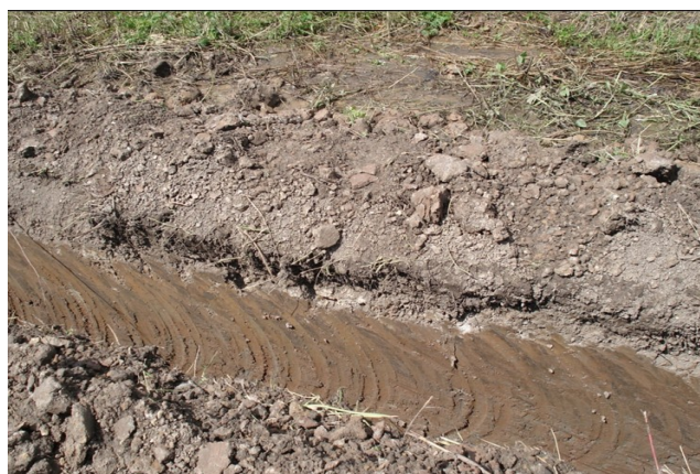
Рисунок 5. – Дренажная траншея на ОПУ «Васюки», суглинистый грунт (июнь 2012 г.)
