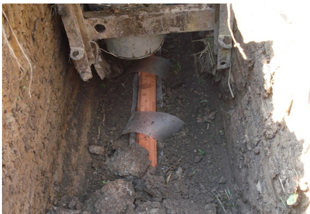
Рисунок 6. – Укладка керамических труб в дренажную траншею с ЗФМ Тураг® SF 27 на ОПУ «Васюки» (июнь 2012 г.)
