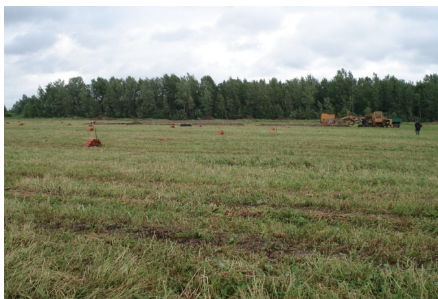
Рисунок 4. – Фрагмент строительства опытных дренажных систем на ОПУ «Васюки» (июнь 2012 г.)
