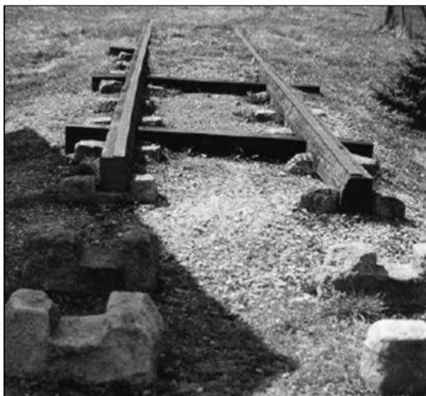
Рис. 3. Укрепленные поверх деревянных лежней чугунные пластины – прообраз современных стальных рельс (фото из [41])
