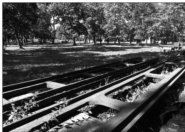
Рис. 4. Сохранившиеся фрагменты чугунных рельсов на территории Александровского пушечного завода (основан в 1788 г.) в г. Петрозаводске (в наст. время «Онежский тракторный завод»). Рельсовый путь длиной 173,5 м связывал доменный, сверильный и расточный цеха. Ширина колеи тогда составляла 0,8 м. Заметно, что профиль рельса в то время был уголковым, а всю конструкцию понимали как некий «монолит» – рельсы отлиты заодно с чугунными шпалами
