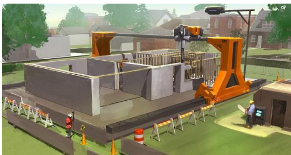
Рис. 5 Конструктивное исполнение строительного 3D-принтера
