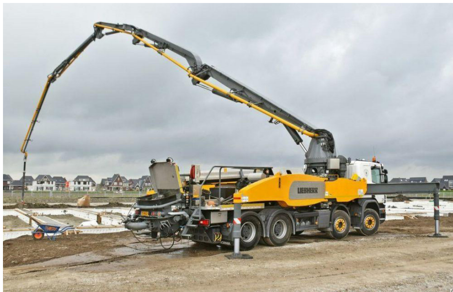
Рис. 7 Подача бетонной смеси в рабочую зону (фото с сайта производителя)
