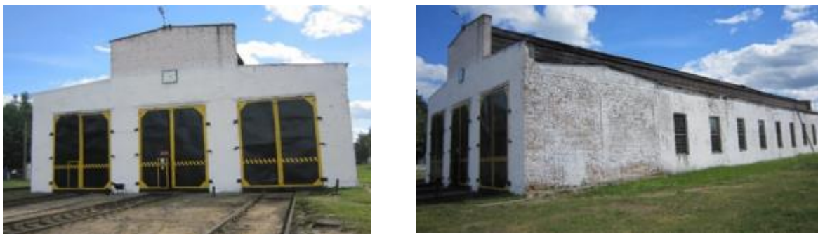
Рис.1. Главный и боковой фасады здания локомотивного депо
