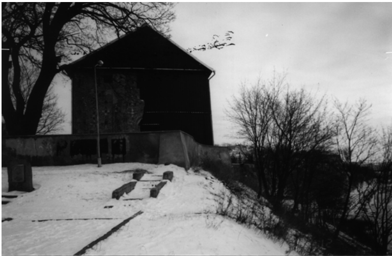
Рис. 42. Здание Каложской церкви в г. Гродно на склоне у р. Неман, часть которой обрушилась при подмыве и активизации оползневого процесса
