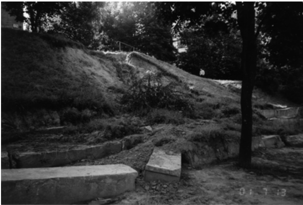
Рис. 18. Образование промоин на откосе при струйчатой эрозии (а) и оврага на склоне за подпорной стеной на ул. Жудро в Минске (б) при нарушении одерновки, что обусловило её обрушение
