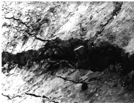
Рис. 43. Оползневые трещины на поверхности грунта при разрушении здания «Беларусбанка» в г. Шарковщина
