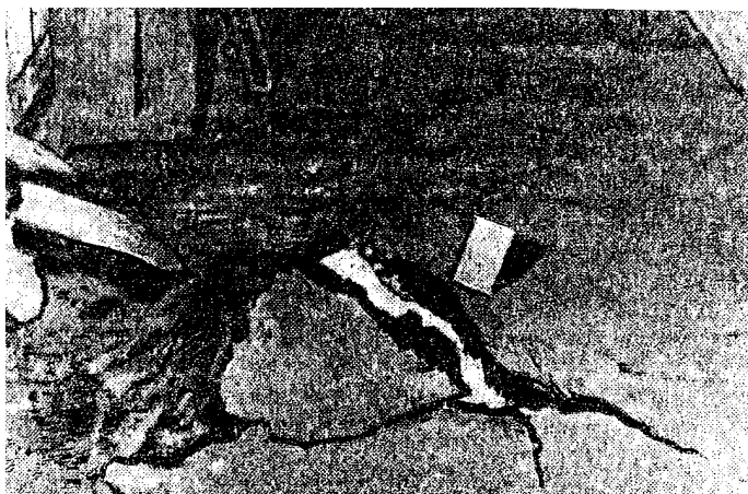
Рис. 15. Разрушение асфальтового покрытия растущими грибами
