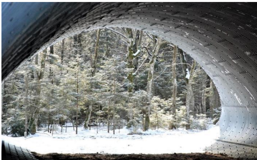
Рисунок 2 – Тоннель для животных на участке трассы М6 Минск-Гродно
