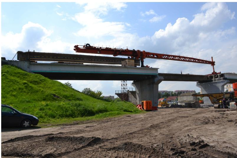
Рис. 4. Демонтаж балки пролетного строения № 5
