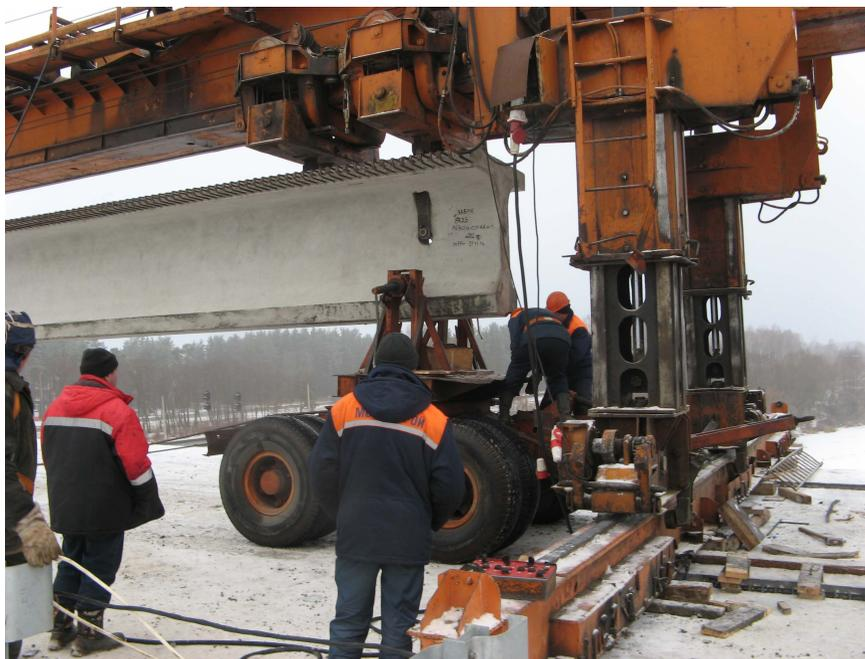
Рис. 10. Подъем балки передней грузовой тележкой с пневмоколесной тележки на высоту 100–200 мм
