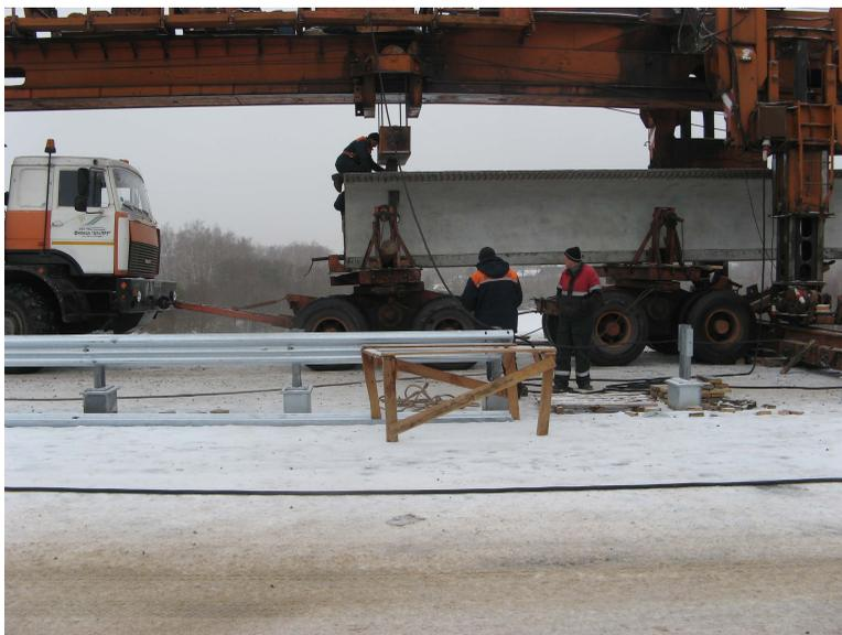
Рис. 12. Строповка балки к траверсе задней грузовой тележки
