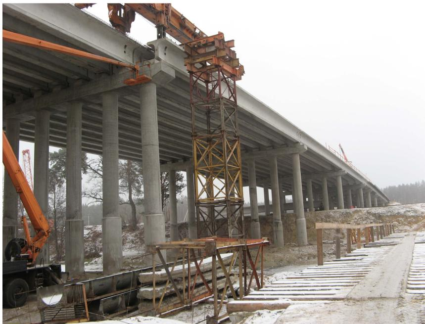
Рис. 16. Конструкция временной опоры под краном КШМ-63 для монтажа крайних балок
