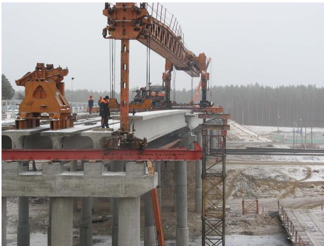
Рис. 15. Перемещение балки в поперечном направлении и установка в проектное положение на опорные части
