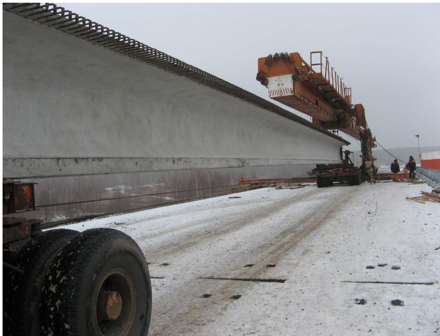
Рис. 7. Монтаж балки пролетного строения с прицепа-тяжеловоза
