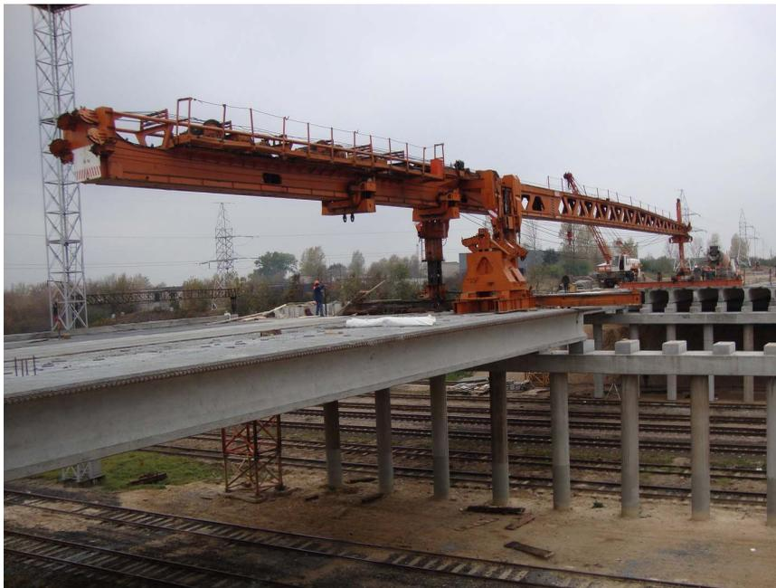
Рис. 1. Монтаж средней балки пролетного строения краном КШМ-63
