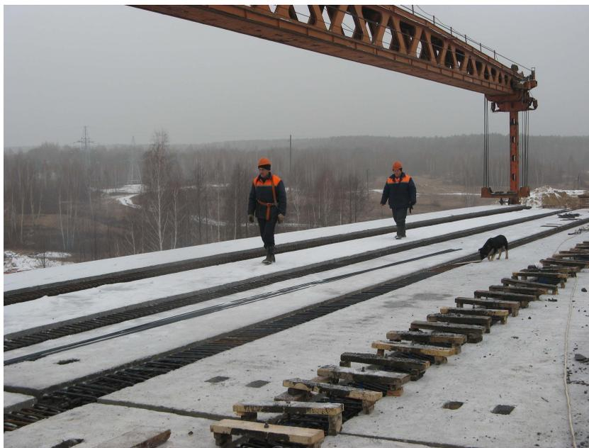
Рис. 8. Работа крана на немоноличенных балках
