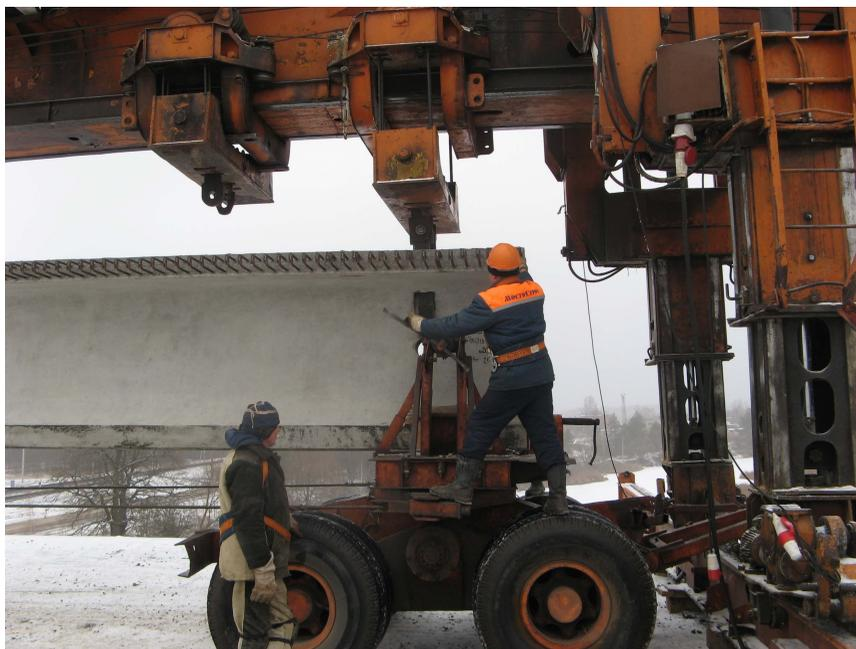
Рис. 9. Установка передней грузовой тележки крана на задней консоли и строповка балки
