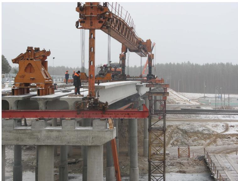
Рис. 2. Монтаж крайней балки пролетного строения краном КШМ-63 с устройством временной опоры
