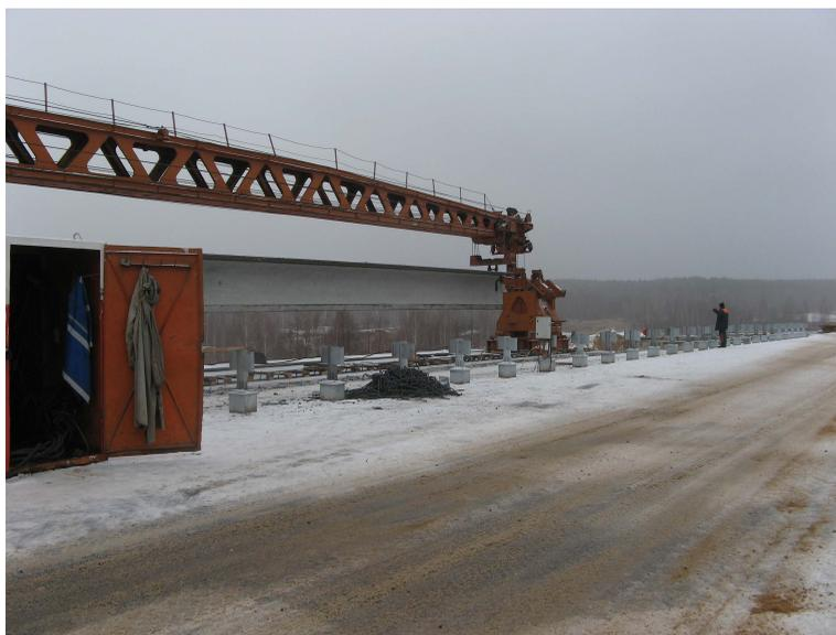
Рис. 13. Перемещение балки в пролет передней грузовой тележкой
