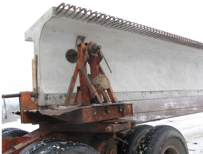
Рис. 6. Опирание балки на тележку прицепа-тяжеловоза
