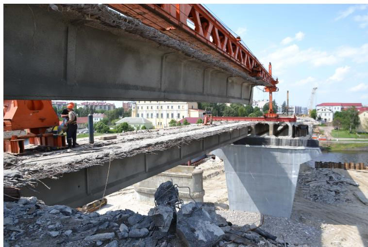
Рис. 3. Демонтаж балки пролетного строения № 1 на мосту через реку Пина
