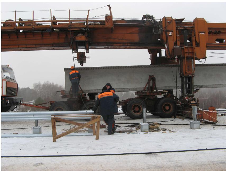
Рис. 11. Перемещение балки для строповки задней грузовой тележкой
