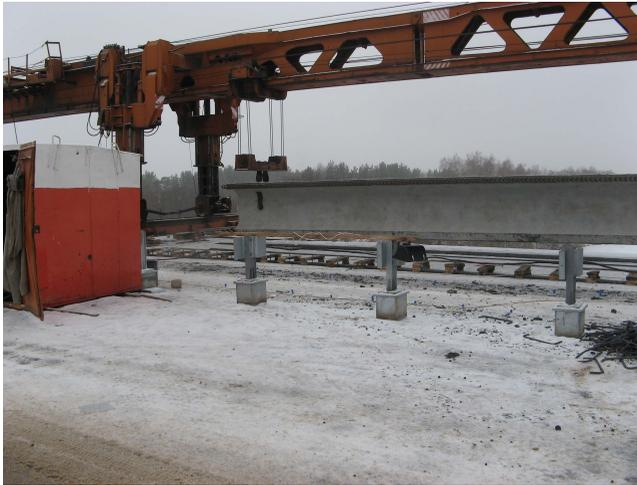
Рис. 14. Перемещение балки в пролет задней грузовой тележкой
