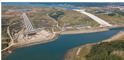
Рис. 4. Загорская ГАЭС: справа – ГАЭС-1; слева – ГАЭС-2 Fig. 4. Zagorskaya PSP: on the right – PSP-1; on the left – PSP-2
