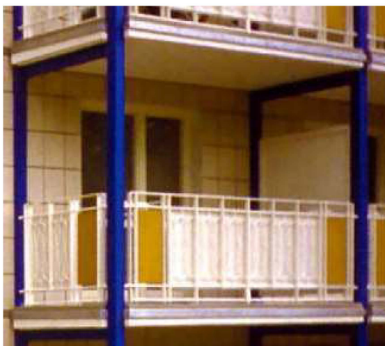
Рис. 7. Приставные лоджии реконструированного крупнопанельного многоэтажного дома в г. Берлине, Германия, 1998 г.
