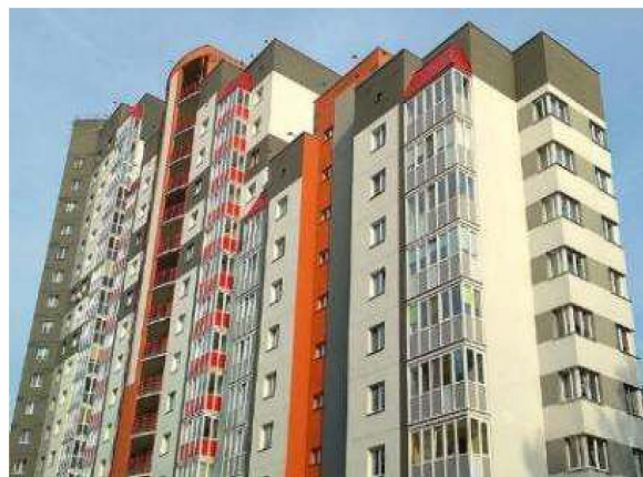
Рис. 6. Многоэтажный жилой дом с остекленными лоджиями в г. Минске
