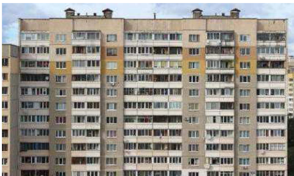
Рис. 2. Южный фасад 12-этажного жилого здания серии М111-90, г. Минск
