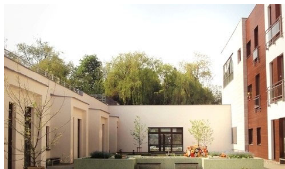
Рис. 5. Центр Альцгеймера. Варшава. Пристройка центра дневной поддержки (2010 г.) к дому престарелых 1974 г. постройки (модернизация 2013 г.)
