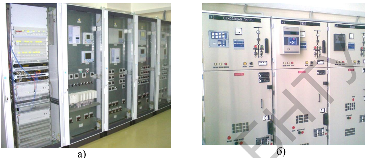
Рис. 1 – Учебно-исследовательский полигон АСУ ЭТО: а) фрагмент полигона АСУ ЭТО; б) фрагмент КРУ 10 кВ
