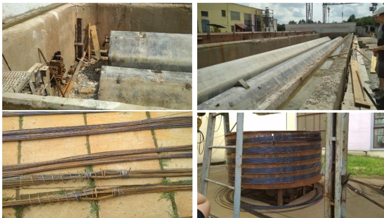
Рисунок 5 – Процесс изготовления анкеров и их использование
