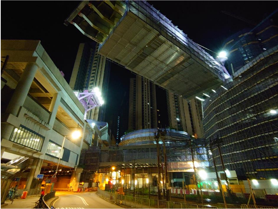
Рисунок 1 – Поворотная надвижка пролётного строения
