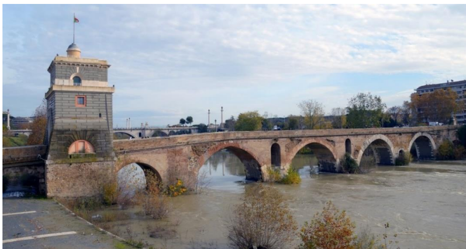
Рисунок 1 – Мост Понте Мильвио через реку Тибр в городе Риме
