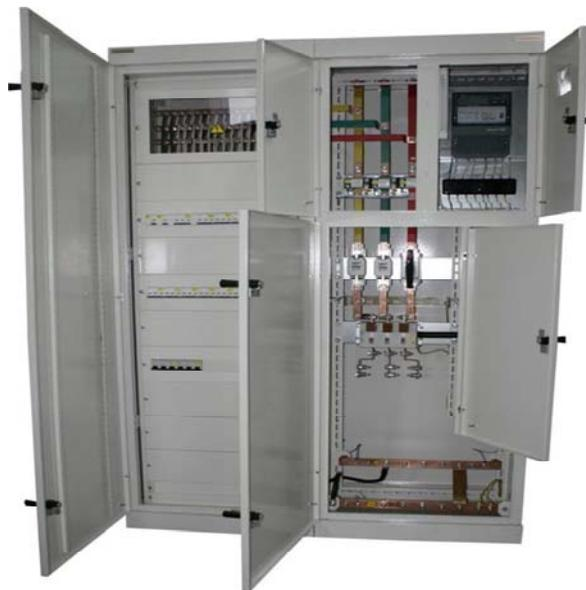
Рис. 4.9. Общий вид вводно-распределительного устройства
