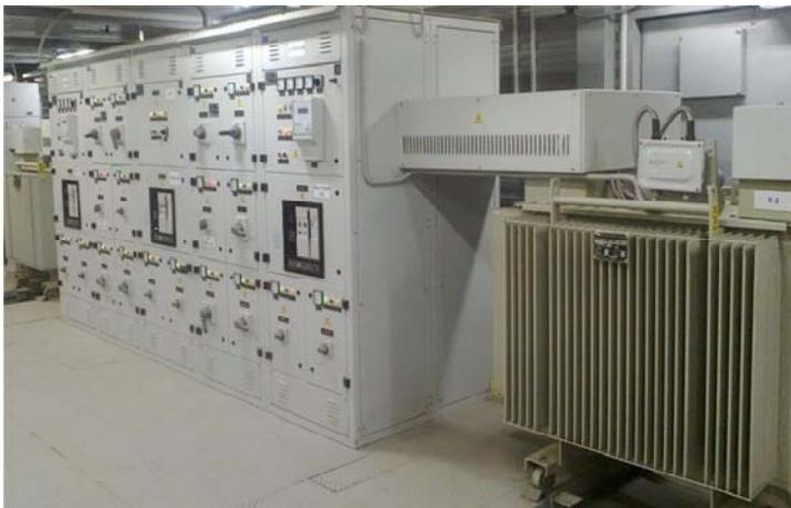
Рис. 4.5. Распределительные устройства низкого напряжения КТП
