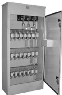
Рис. 4.1. Общий вид распределительного шкафа (с предохранителями)
