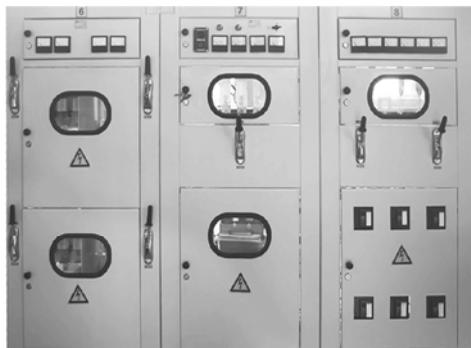
Рис. 4.2. Общий вид распределительного щита типа ЩО (П)
