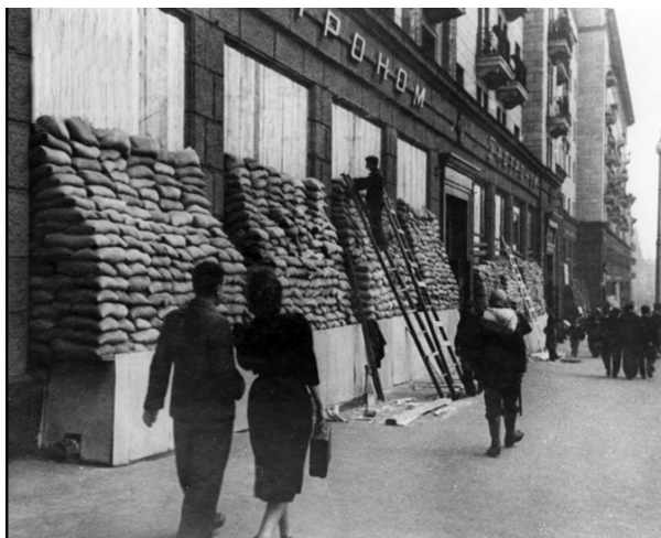
Рис. 6.6. Усиление зданий обкладкой мешками с песком
